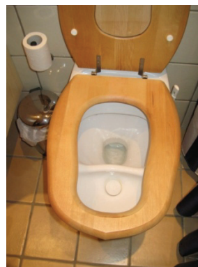
Figura 6: Inodoro con separación de orina y descarga de agua para heces
