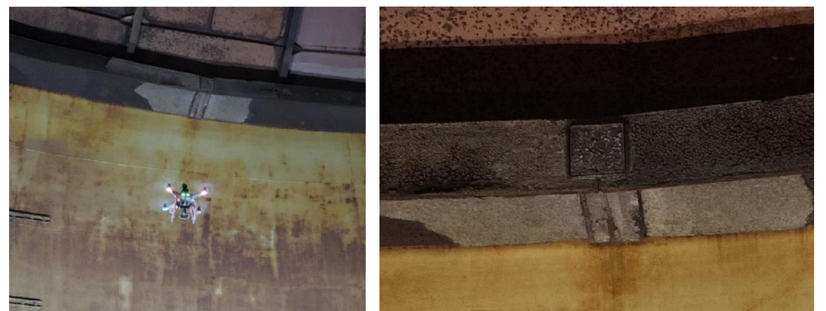
• Detalle de inspección interna del tanque
