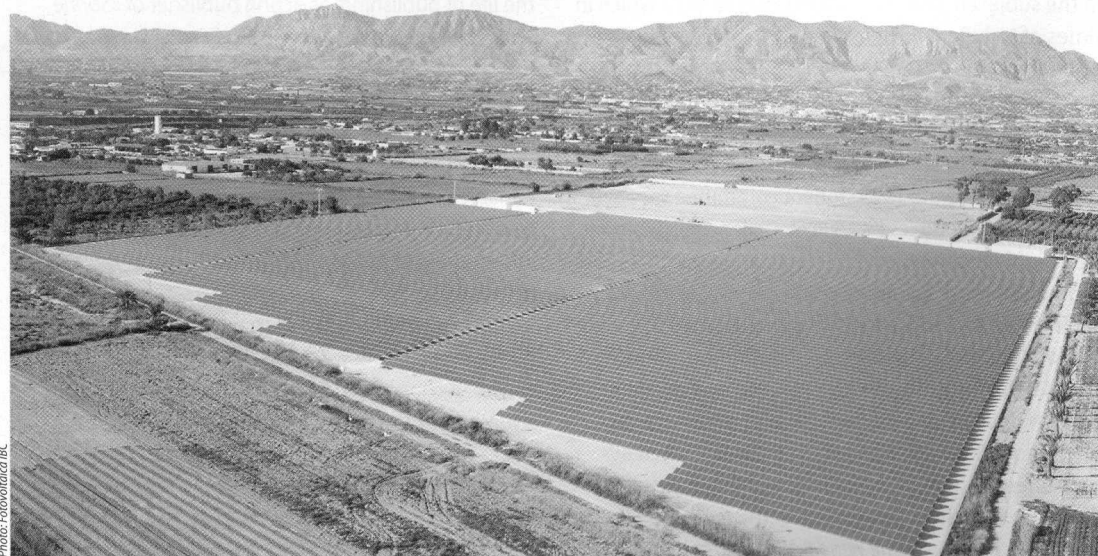
Photo: Fotovoltaica IBC
